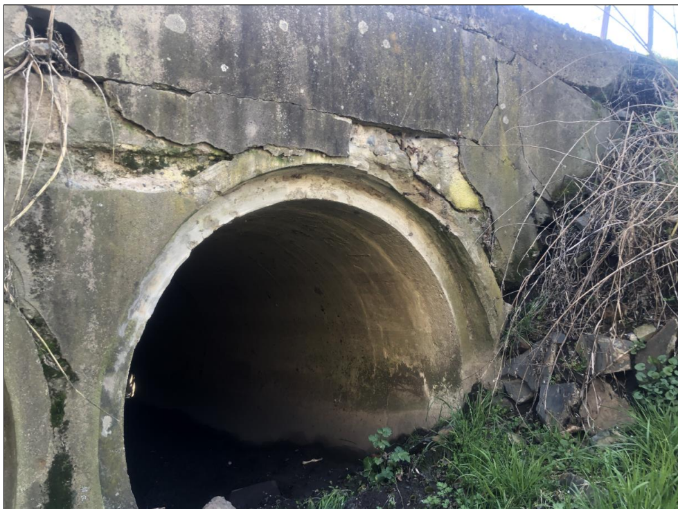
Obr. 4: Potrhaný beton na čele propustku, povodní strana.
