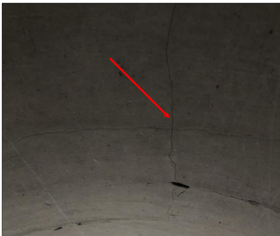
Obr. 8: Trhliny do 0,3 mm na podhledu betonové trub
