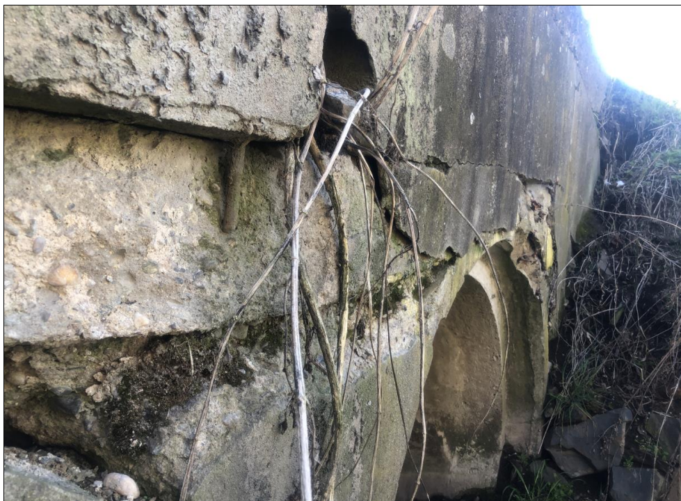
Obr. 5: Potrhaný beton na čele propustku, odprýskané vrstvy, prorůstající vegetace, povodní strana.
