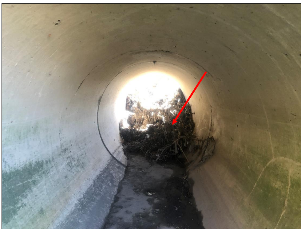
Obr. 7: Zachycené větve a nánosy na návodní straně konstrukce
