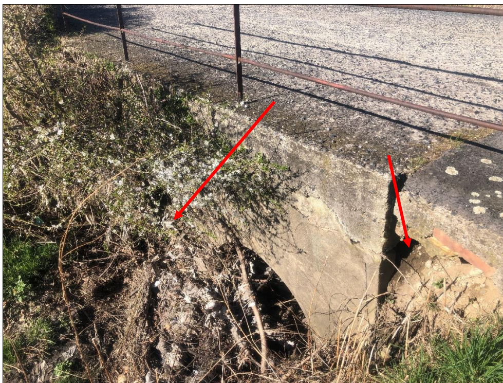
Obr. 6: Zachycené větve na návodní straně propustku, vymleté přechodové oblasti objektu
